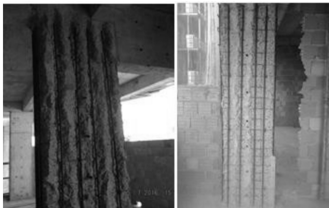
Foto 1: Barras suplementares nos pilares P17 e P28 (respectivamente)
