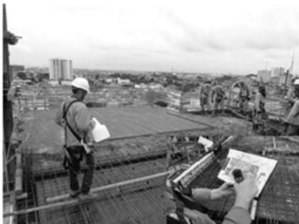
Figura 3: Levantamento das áreas concretadas (croqui)
