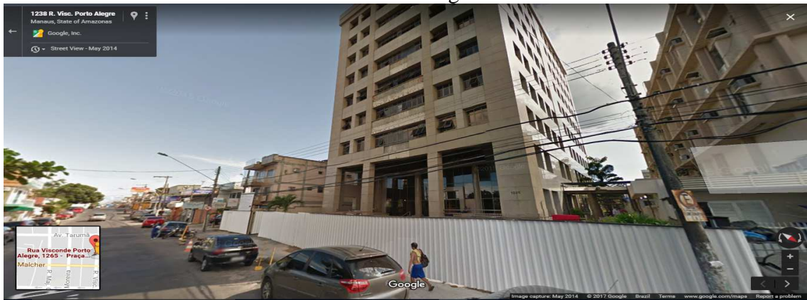
Foto do Prédio Sede – Rua Visconde de Porto Alegre
